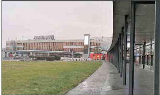
Ein letzter Besuch: Zum Familienfest im September öffnen sich die Türen des ehemaligen Flughafengebäudes zum letzten Mal. Foto: sos
