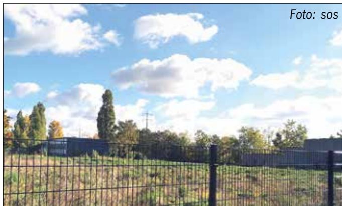
Hinter dem Schönefelder Gymnasium soll an der Pestalozzistraße eine neue Kita entstehen. Das Bauverfahren kommt gut voran.
