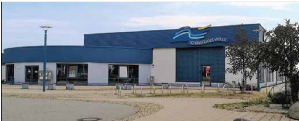
Die Schwimmhalle Schönefelder Welle wurde für 7,3 Millionen Euro erbaut und im Jahr 2011 eröffnet. Jetzt muss sie für mindestens rund 3 Millionen Euro saniert werden. Foto: sos
